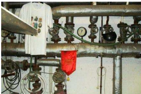
6.kép A felújításra váró szabályozó szeleprendszer
