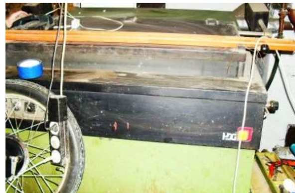
5.kép A régi vegyes tüzelésű HDG Safental 180 kW-os kazán
