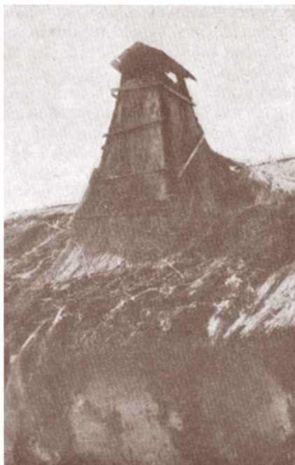
11. Fonolt sárkémény felsőrésze a tető fölött hátulról nézve. — Abb. 11. Geflochtener Rauchfang über dem Dach.
