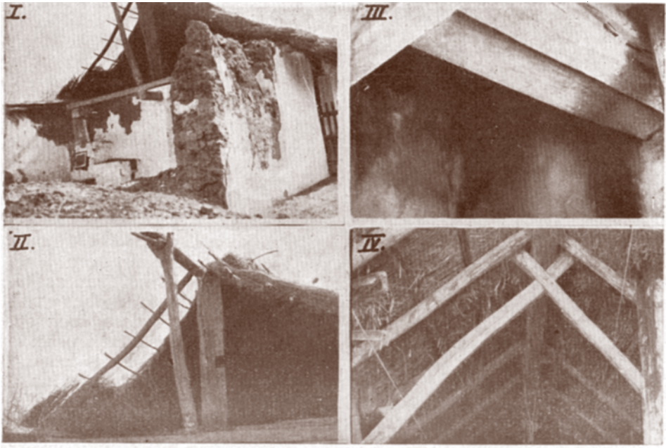
8. ábra. I—II. Ágasoszlop a keresztgerendán felette lévő szelemennel. — Abb. 8. Gabelpfoste auf dem Querbalken. Oben Pfette. III. A szabad, fonott sárkémény alsó tartógerendája alulról nézve. — III. Die Grundbalken des Rauchfanges aus Ruten geflochten. IV. Ollólábon nyugvó szelemen. — IV. Pfette auf dem Scheerenholz.
