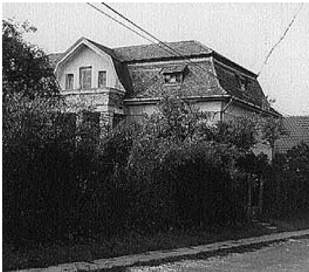
A volt Hitelszövetkezet épülete (ma önkormányzati tulajdonban lévő szolgálati lakás)
